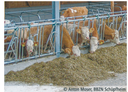
Für Mutterkuhställe eignen sich spezielle Fressgitter. Damit sich die Kälber nicht im Gitter verfangen, ist es so konzipiert, dass es sich auch nach unten öffnet.
